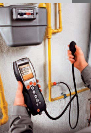
Test plynového rozvodu
